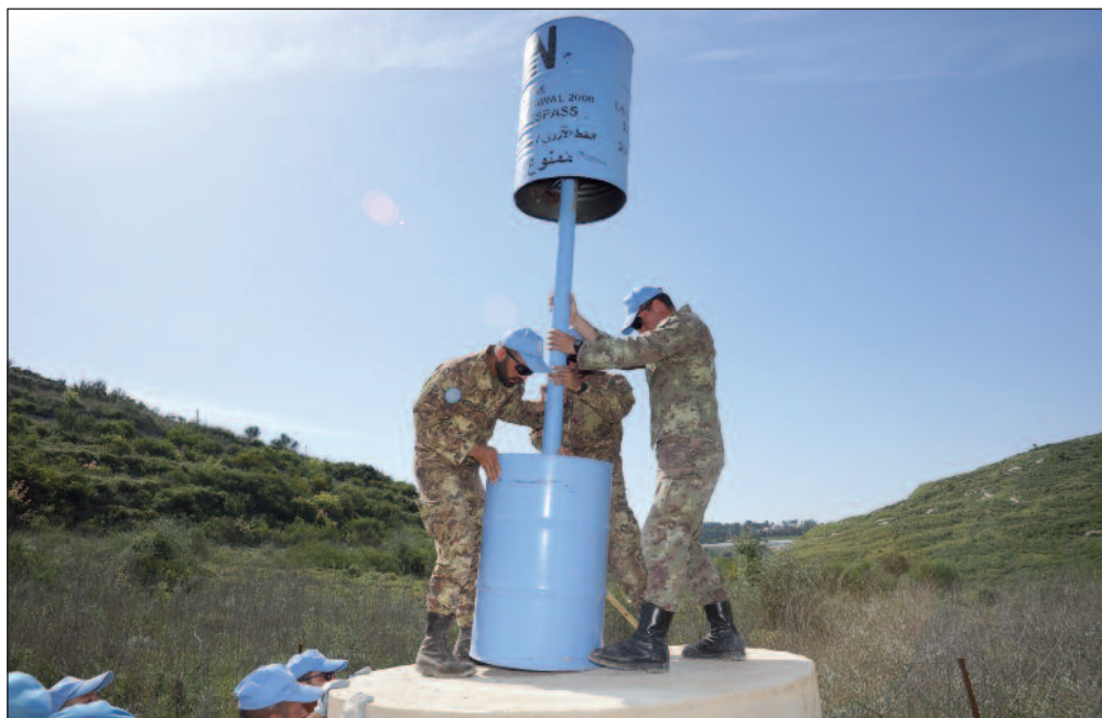
Posa di una Blue Pillar.
