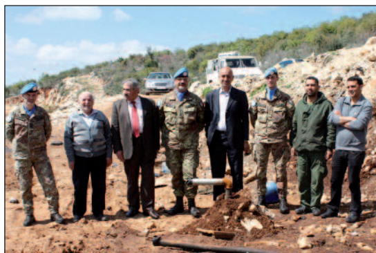
Consegna di un pozzo a Yatar Il 28 marzo 2014, i militari appartenenti alla cellula di cooperazione militare e civile (CIMIC) hanno consegnato presso la municipalità di Yatar un pozzo, realizzato con fondi nazionali, che garantirà l'utilizzo di acqua potabile a circa 11.000 abitanti della cittadina libanese e dei comuni limitrofi. La consegna è avvenuta durante una cerimonia alla quale erano presenti il sindaco, Mohamad Balaghi, e il responsabile del CIMIC italiano, Colonnello Mauro Arnò.
