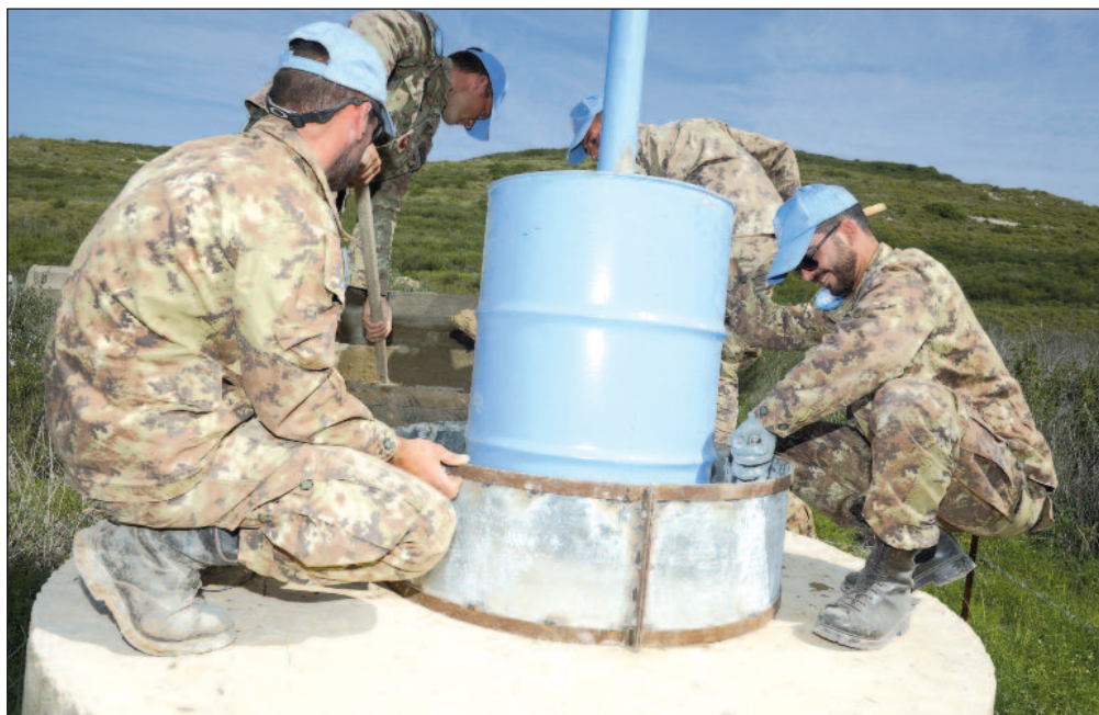
Messa in posa di un Blue Pillar.
