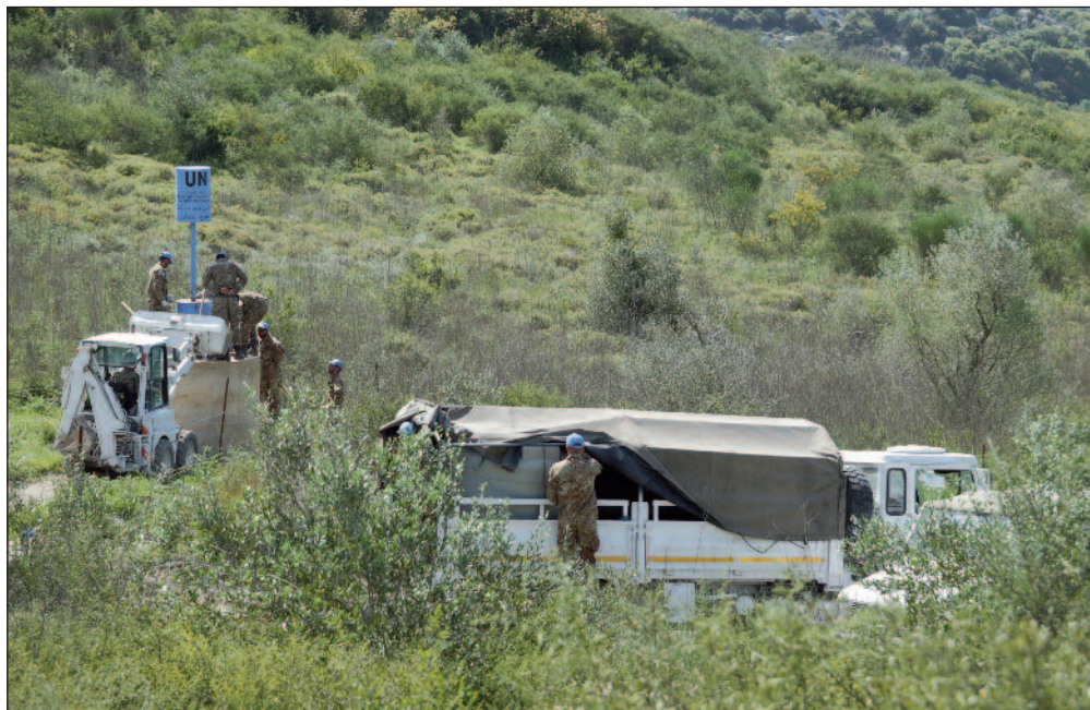
Posa di un Blue Pillar.
