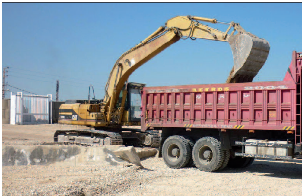
Attività per lavori infrastrutturali.
